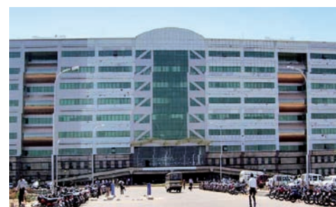
Edificio ETL, India
